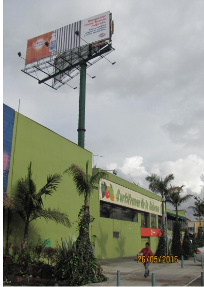
FOTO No.1 – Vista panorámica N-S
